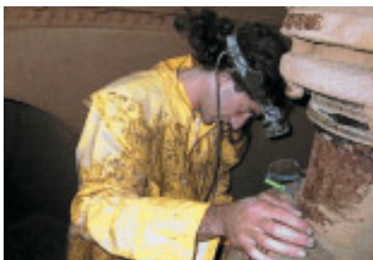
Zwei Kubikmeter Wasser fließen pro Sekunde in den Oberwasserkanal (unten) des Wespi-Mühle-Kraftwerks. Zu dessen Revitalisierung gehören auch Unterhaltsarbeiten: Urs Gähwiler befreit den Turbinenschacht von Geschwemme und Kalk.
