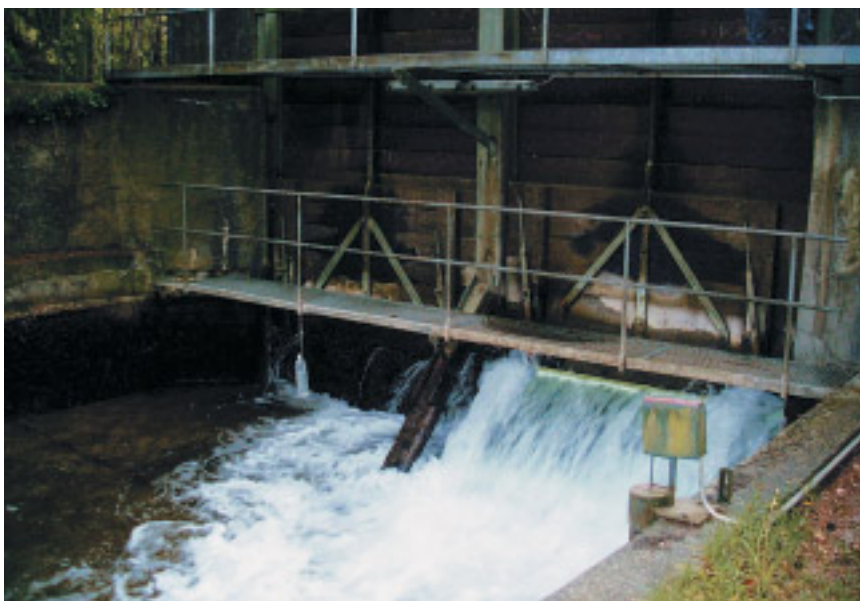
Fondation Revita, Langenbruck BL
