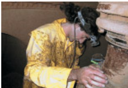
Le débit atteint 2 m 3 par seconde dans le canal de dérivation du moulin Wespi, près de Winterthur. Des travaux d'entretien sont indispensables: Urs Gähwiler libère la turbine du calcaire et des débris.
