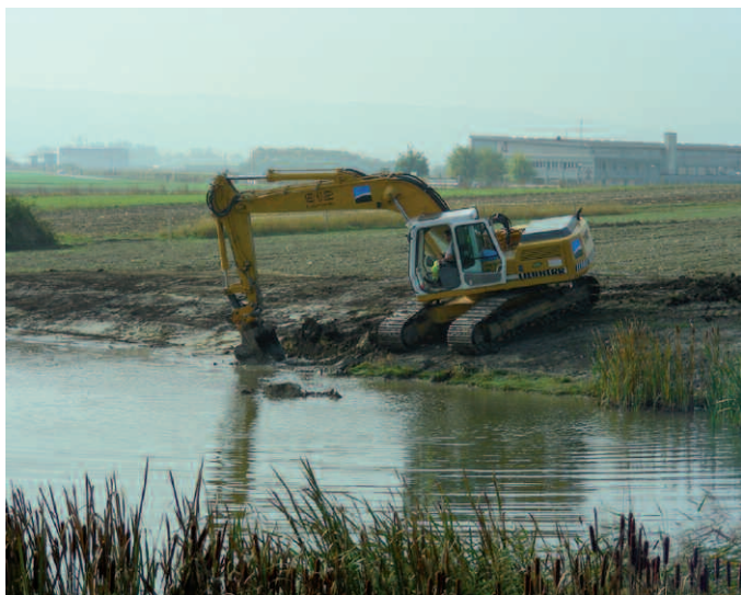
Fig. 2: Pré Bovet: terrassement 2004.
