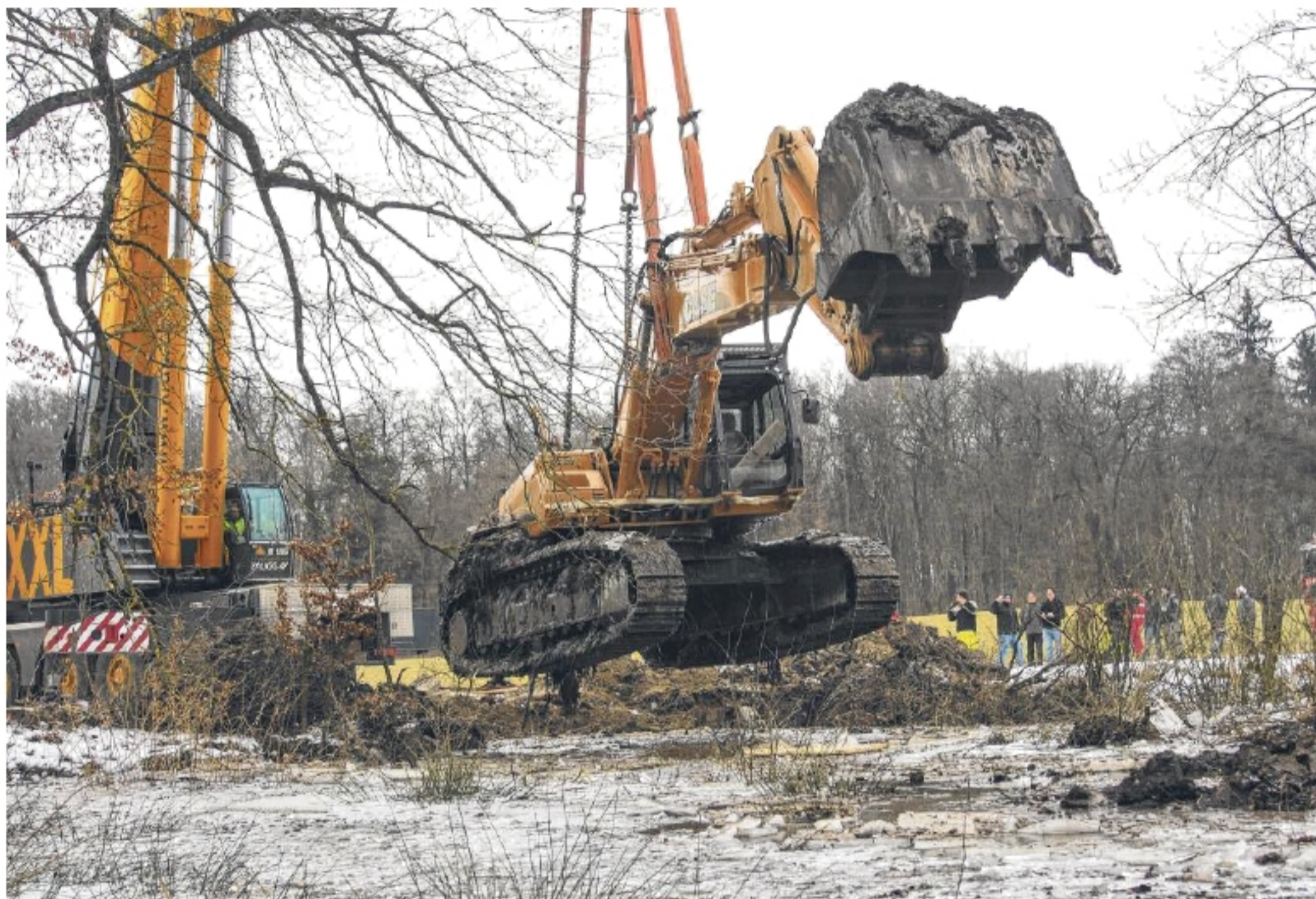
Nach einem mehrstündigen Einsatz kann ein Kran den 50 Tonnen schweren Bagger aus dem Moos herausheben.
